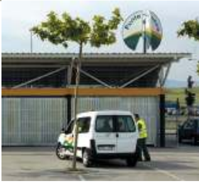
Punto limpio fijo
